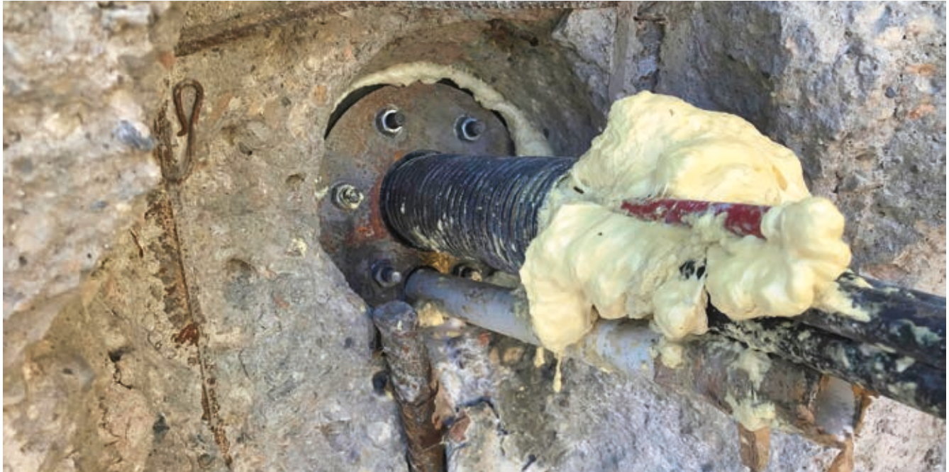
Injektion zur Abdichtung an einem Ankerkopf
