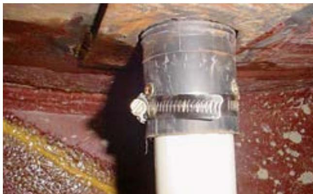
6. Afin de garantir une bonne séquence d'injection, les tubes de remplissage doivent être identifiés par des couleurs différentes.
