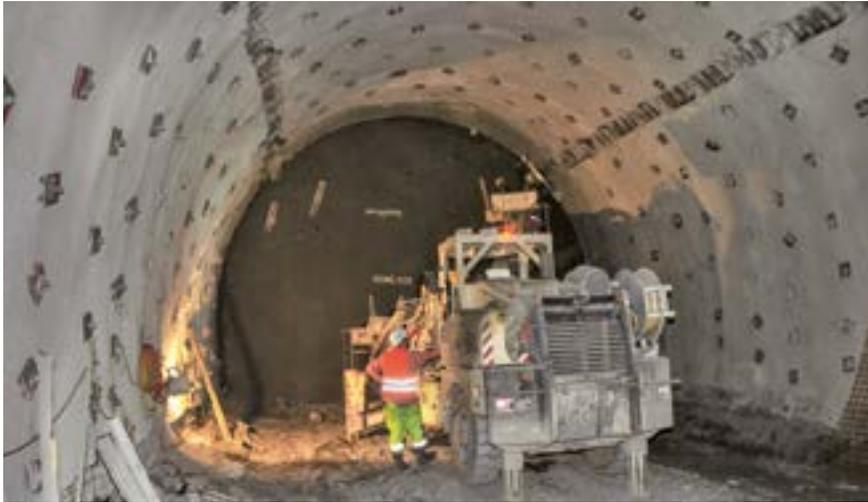
L'application des éléments LSC™ augmente la sécurité au travail, limite les déplacements et évite les dommages supplémentaires au sol et au béton projeté. Outre l'utilisation de systèmes de soutènement ductiles tels que les éléments LSC™, l'installation de boulons ayant une capacité d'élasticité accrue est nécessaire.
