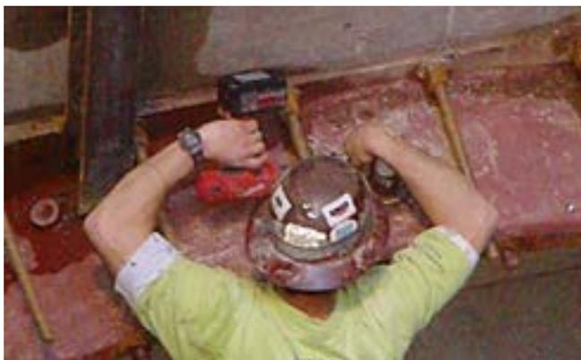
5. Fixation des tubes de remplissage dans les vannes de remplissage BULLFLEX®.
