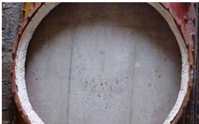
4. Fixation du joint torique BULLFLEX® dans la zone inférieure.
