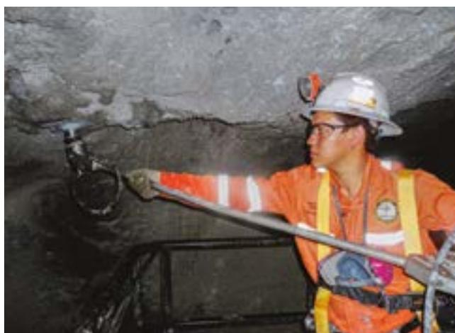
3. Dilatation de l'OMEGA-BOLT® avec de l'eau à haute pression.
