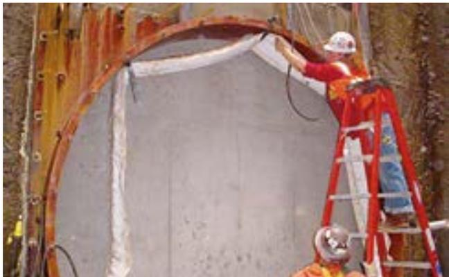
1. Montage du joint torique BULLFLEX® pour le marquage des points de soudure.
