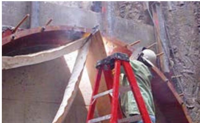
2. Soudage de boulons/goujons sur le support de scellement
