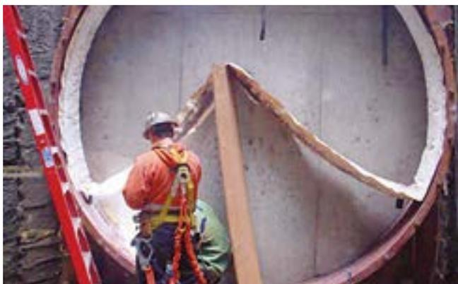
3. Fixation du joint torique BULLFLEX® dans la zone supérieure.
