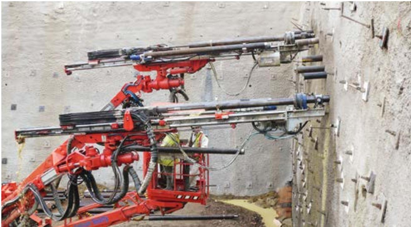
1. Pour le forage, l'unité de démarrage avec foret équipée d'un foret est assemblée sur une flèche de forage avec le tube de rallonge AT, l'adaptateur AT et la tige de forage.
