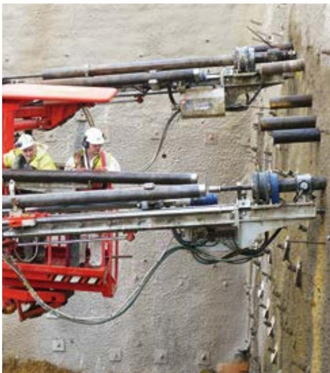
3. La tige de forage suivante avec le tube de rallonge est raccordée au tube précédemment installé et le processus de forage se poursuit. Rechargement de l'unité d'automatisation AT (tube de rallonge et tige de forage).
