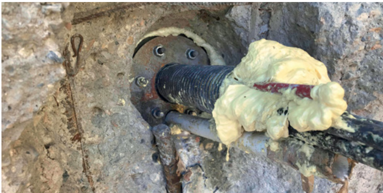
Injektáž pro utěsnění na hlavě kotvy
